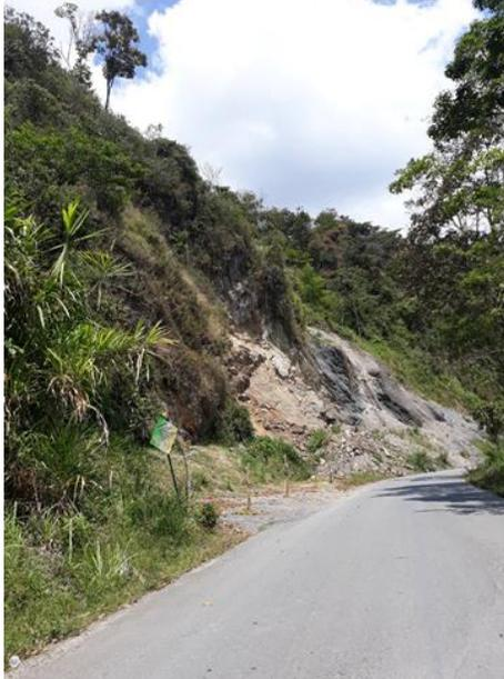
Figura. 97. Movimiento en masa en el talud superior de la vía.
