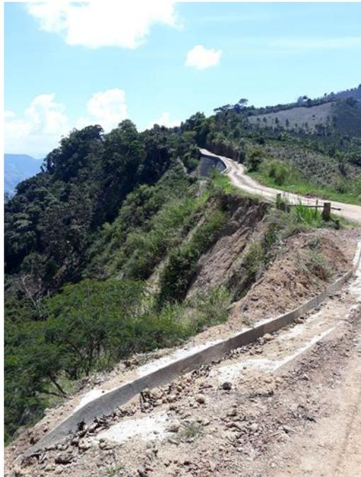
Figura. 67. Movimiento en masa en el talud inferior del sector conocido como La Delgadita.
