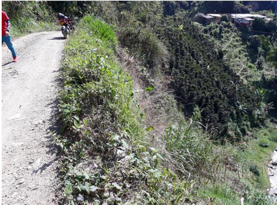
Figura. 81. Movimiento en masa en el talud inferior de la vía.
