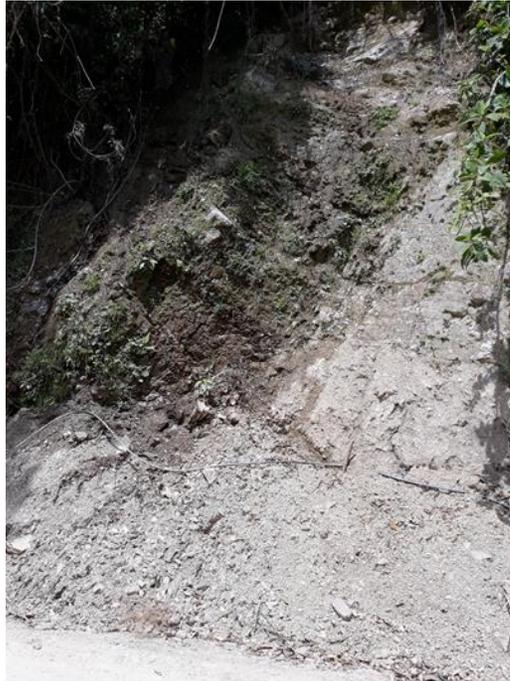
Figura. 59. Movimiento en masa por caída de rocas.
