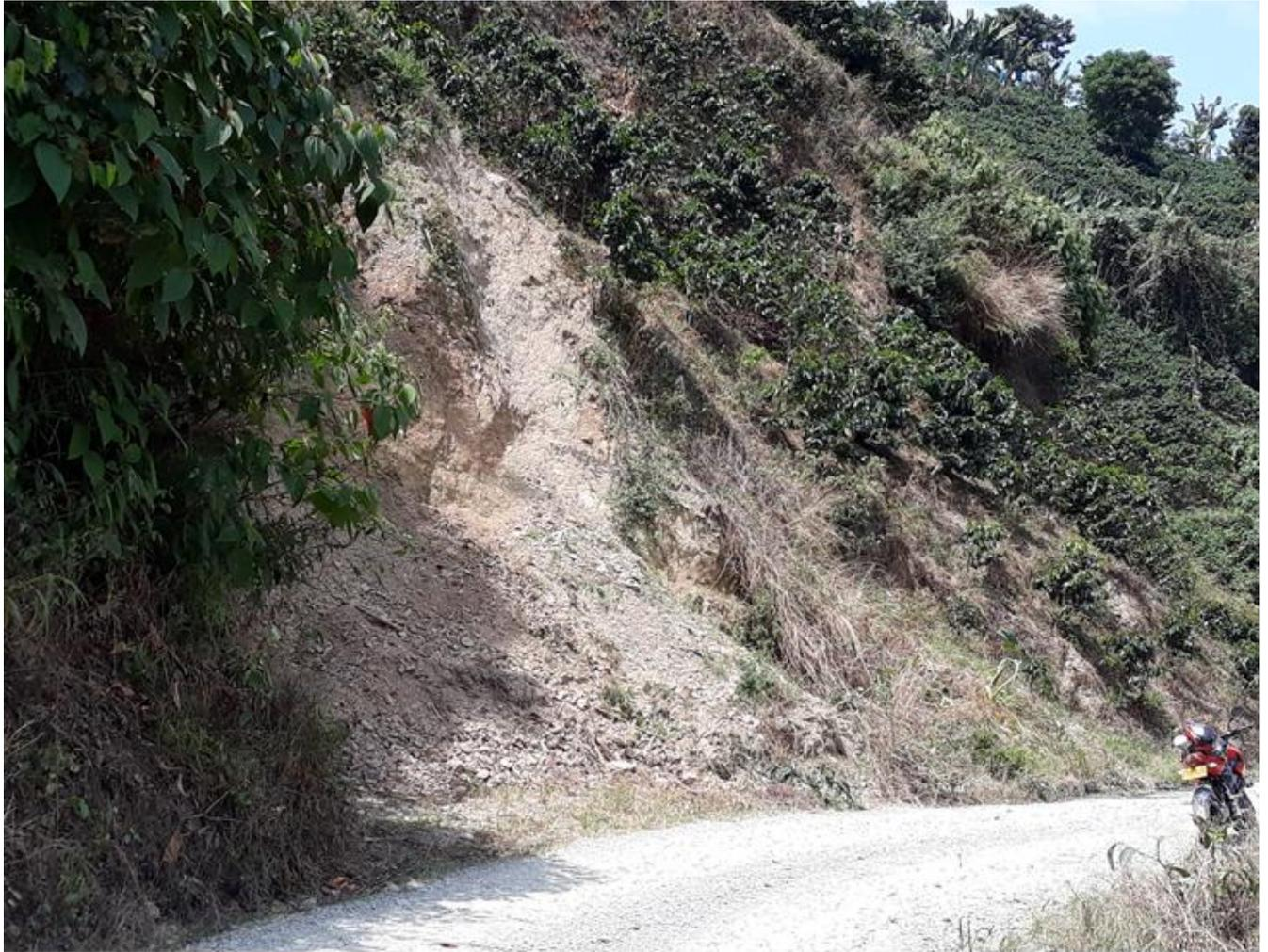
Figura. 90. Movimiento en masa en el talud superior de la vía.
