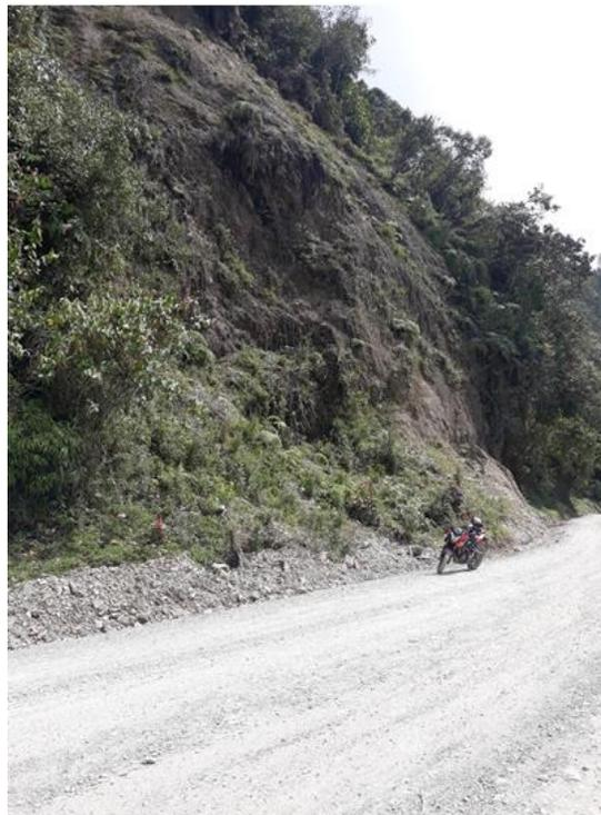
Figura. 51. Movimiento en masa por caída de rocas.
