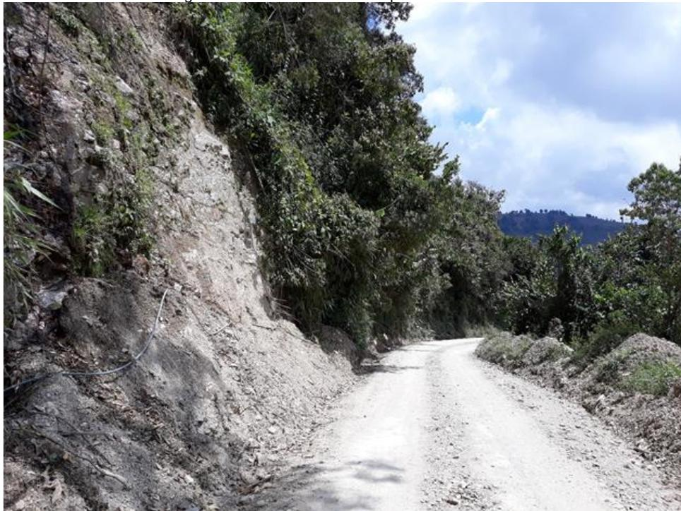
Figura. 60. Movimiento en masa por caída de rocas en la parte superior del talud de la vía.
