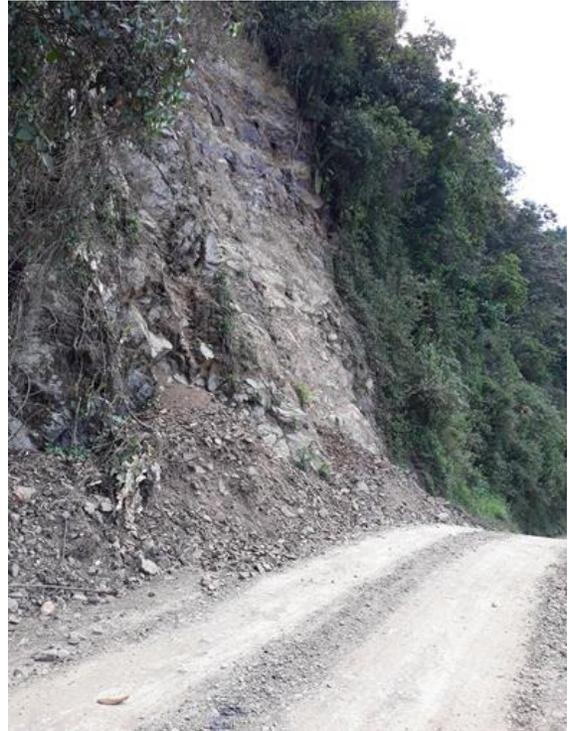
Figuras. 61 y 62. Movimiento en masa por caída de rocas.
