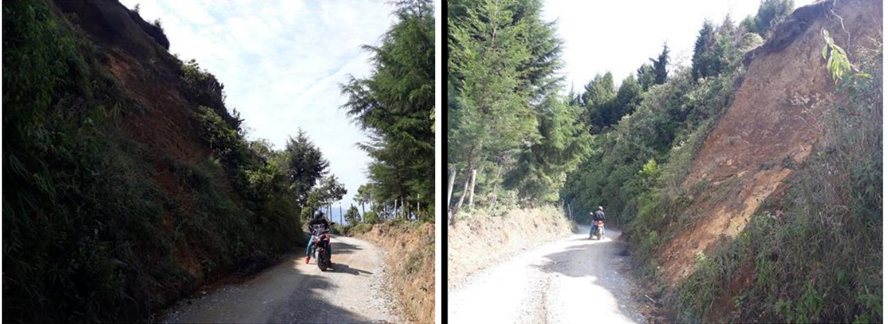
Figura. 73 y 74. Movimientos en masa en el talud superior de la vía.
