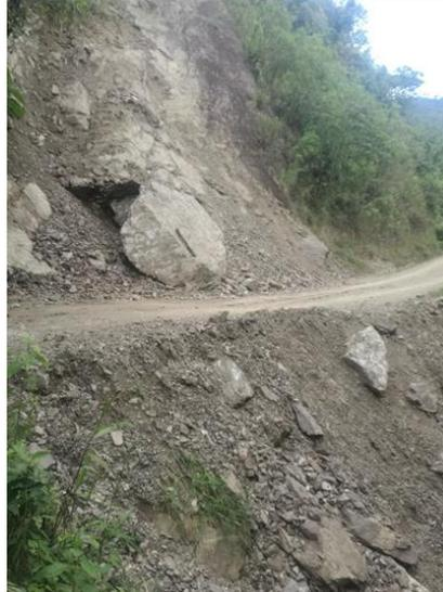
Figura. 71. Movimiento en masa por caída de rocas.
