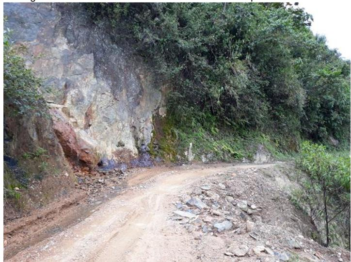
Figuras. 88 y 89. Movimiento en masa por caída de rocas.
