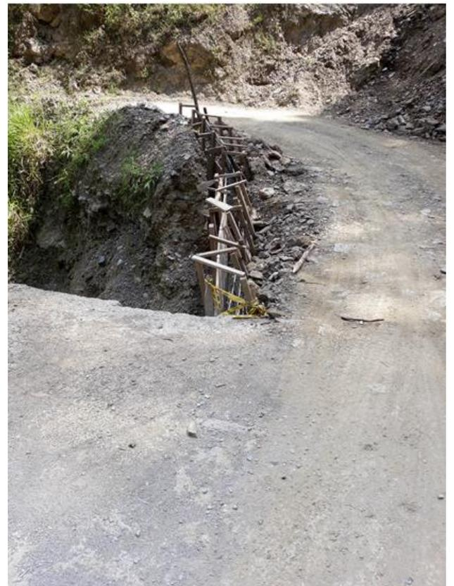
Figuras. 85 y 86. Movimiento en masa cerca del puente La Chuscala.
