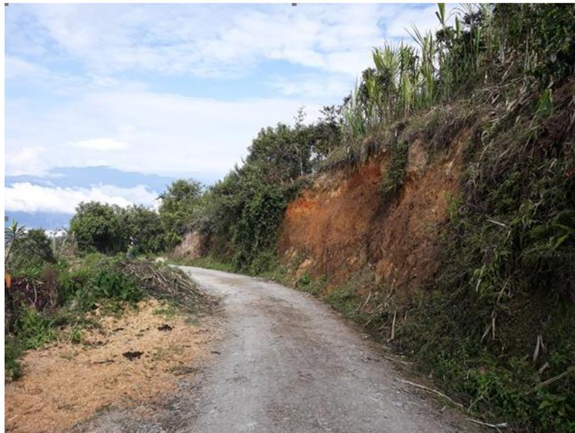
Figura. 72. Movimiento en masa en El talud superior de la vía.
