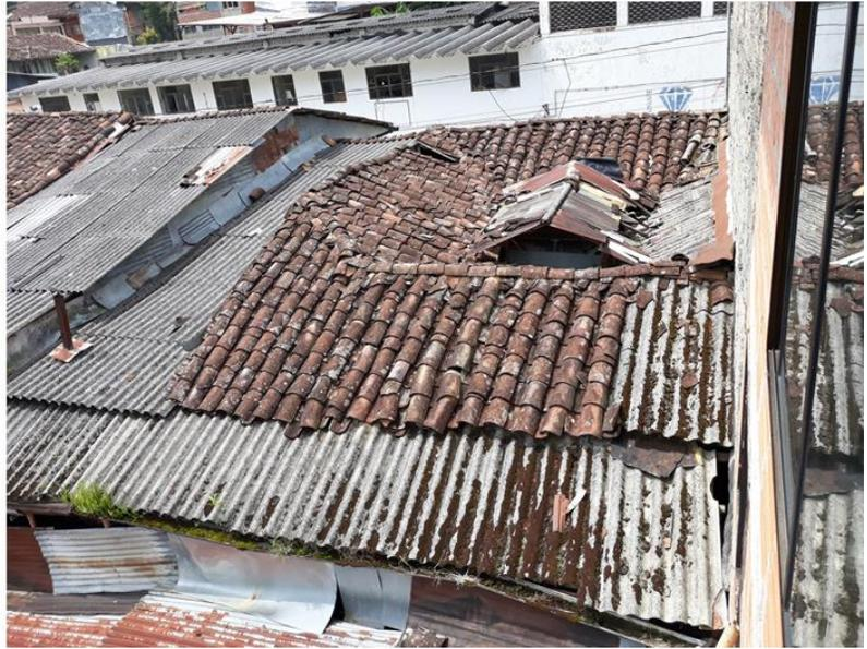
Figura. 23. Techos de viviendas en mal estado en el sector comercial.
