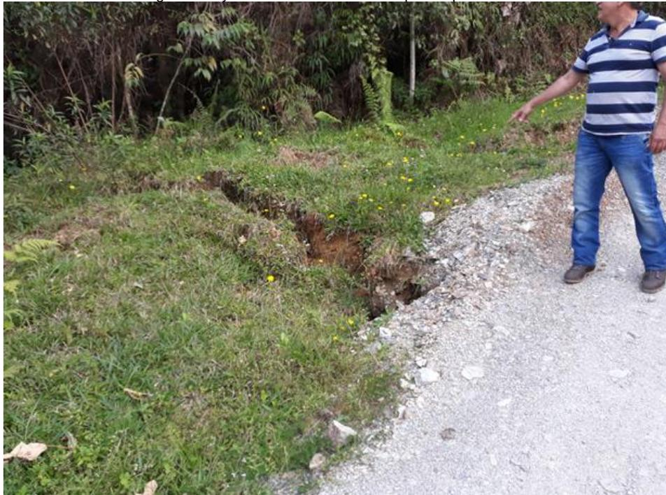
Figura. 96. Asentamiento generados por desplazamiento en la vía.
