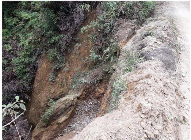
Figuras. 57 y 58. Movimiento en masa en el talud superior de la vía.
