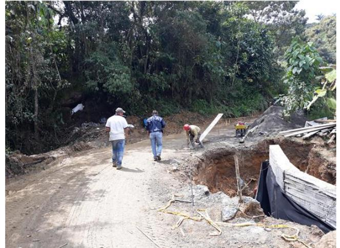
Figuras. 68 y 69. Movimiento en masa en la parte inferior del talud de la vía.
