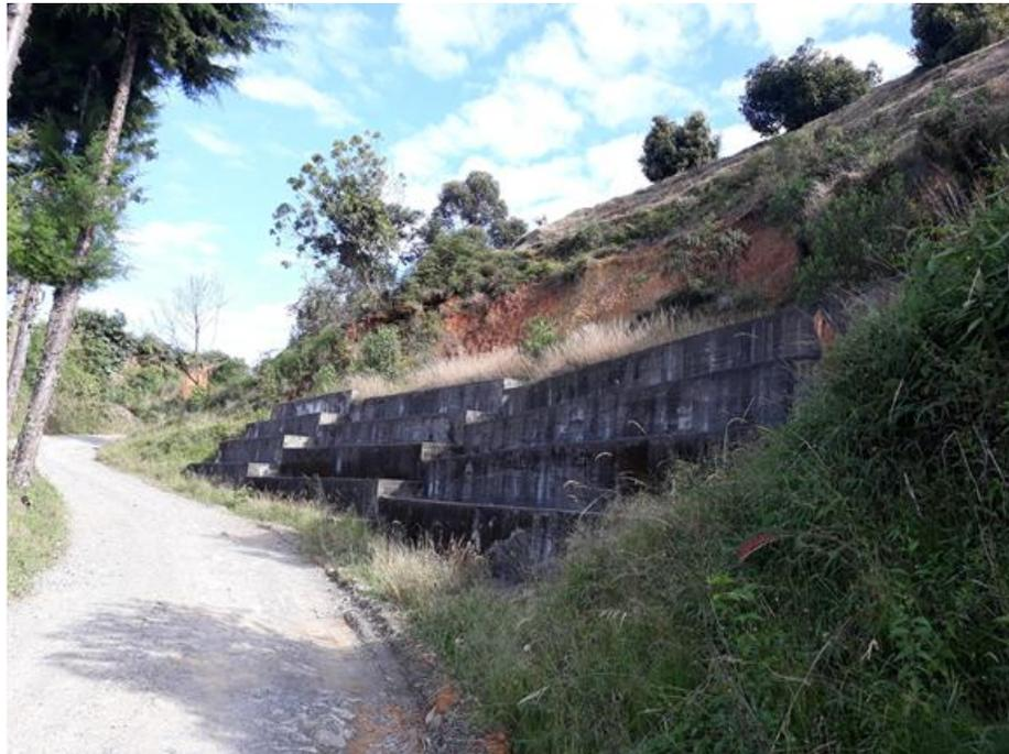
Figura. 78. Movimiento en masa con estructuras de contención en la parte inferior.
