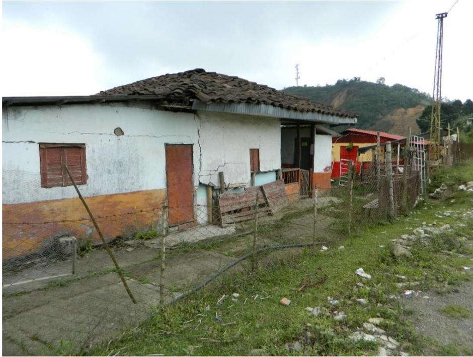
*Ilustración 32.* Fotografía de viviendas en el sector Salón Rojo de tipo de edificación estructuras ligeras representadas por muy bajo grado de resistencia.
