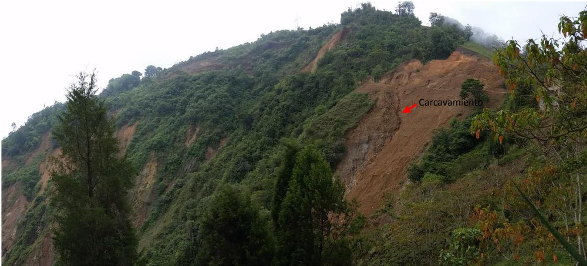
*Ilustración 18. Panorámica deslizamientos traslacionales, desprendimiento del suelo y evidencia de la profundidad del Carcavamiento en el sector Salón Rojo.*
