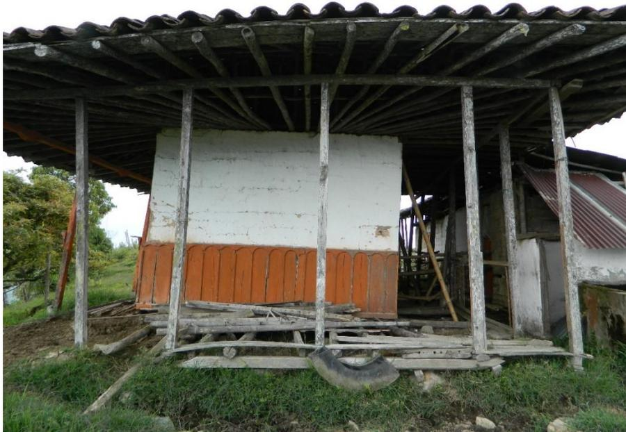
*Ilustración 31.* Fotografía de una de las viviendas en el sector Salón Rojo construida con bahareque y que está siendo afectada por procesos morfodinámicos en la zona.
