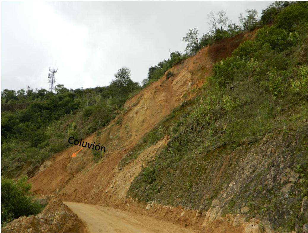
*Ilustración 5. Suelo residual y Coluviones en forma de abanico en la vía.*
